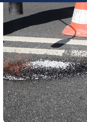
4. Důkladně materiál rozežřejte pomocí hořáku. Aplikujte další vrstvu, je-li to zapotřebí. Finální horkou vrstvu posypte zdrsňujícím materiálem.
