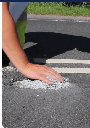
3. Rozproštění vrstvy hmoty ChipFill® v tenké vrstvě (max. 15 mm).
