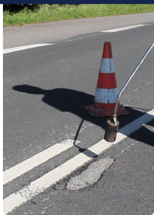
2. Odstranění vlhkosti zahřátím pomocí hořáku, tak aby bylo aplikované místo zcela suché.
