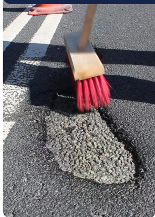
1. Důkladné vymetení (vyfoukání) nečistot z opravovaného výmolu či prasklin.
