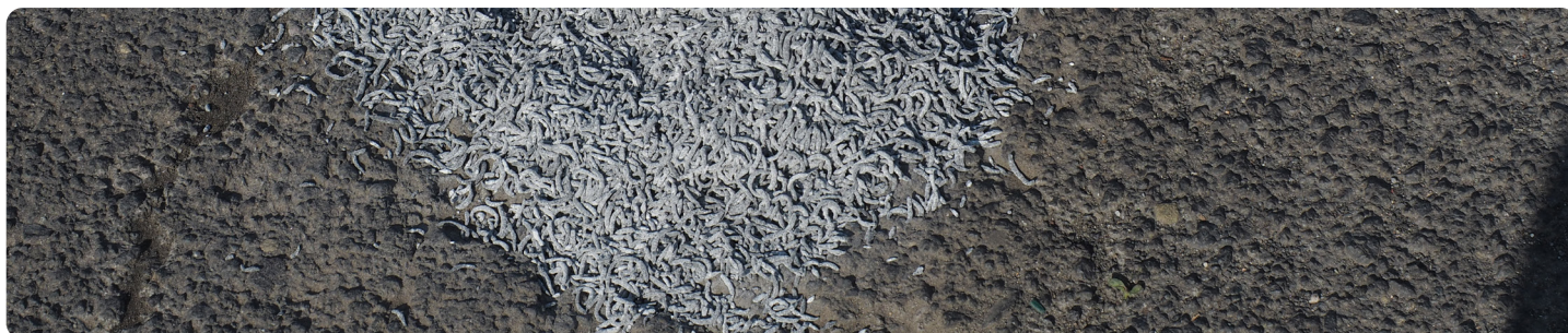
4. Důkladně materiál rozežřejte pomocí hořáku. Aplikujte další vrstvu, je-li to zapotřebí. Finální horkou vrstvu posypte zdrsňujícím materiálem.
